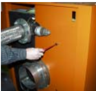
Винтовое крепление частей обшивки к задней чугунной секции
